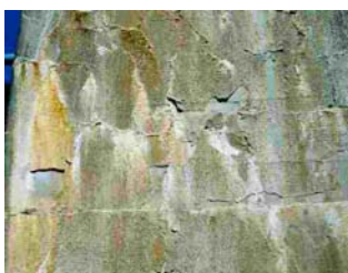
Avfasett overflatebehandling på dam
