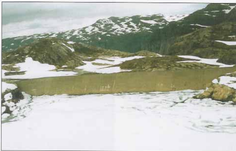
FIGUR 1 Dam Langevann, dam 1, fotografert fra helikopter sommeren 2000. Merk feltene med reparasjoner som ble utført i 1997.
