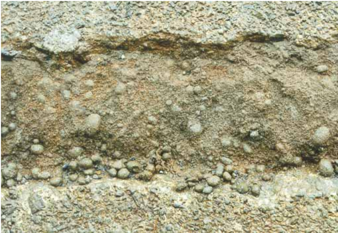
Foto 3 Detalj av reparasjon utført for hånd med pellets og smuldrende konsistens
