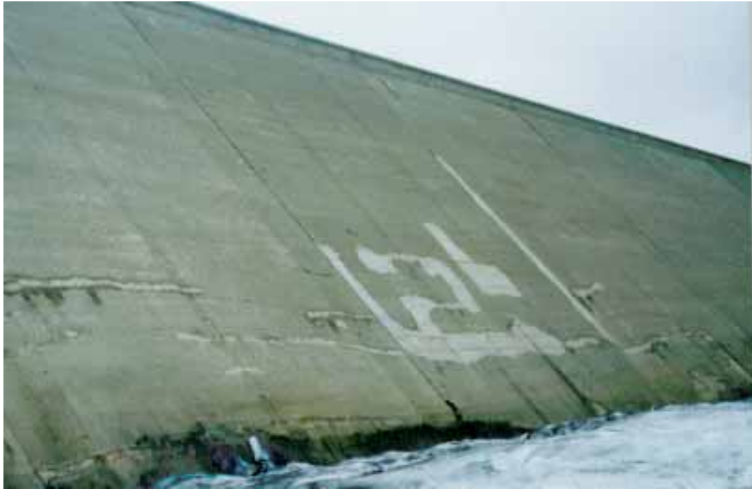
Foto 1 Reparasjoner i damplater sett fra vannsiden
